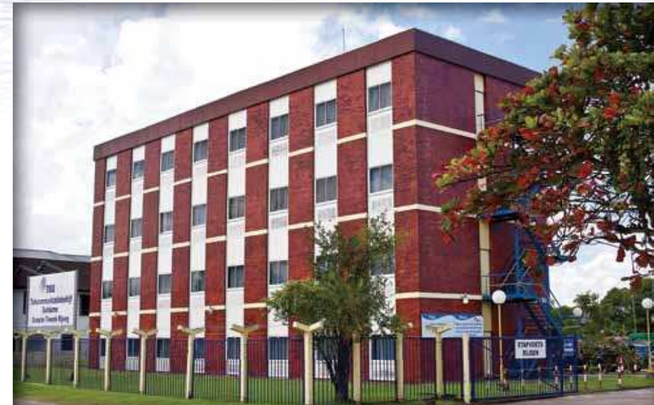
Telesurgebouw aan de Tweede Rijkweg.
