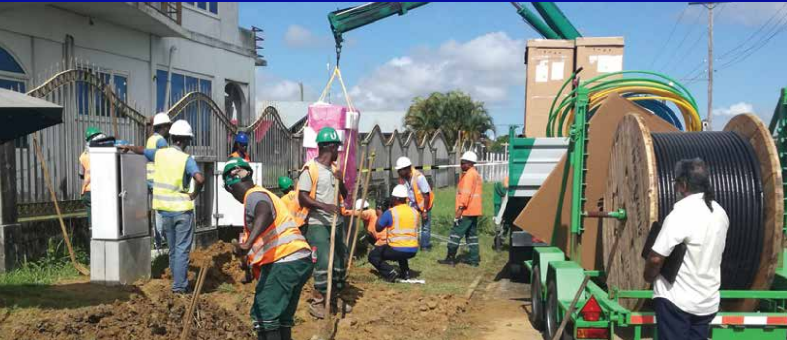
Plaatsing MSAN op fundatie ad Morgenstondlaan.
