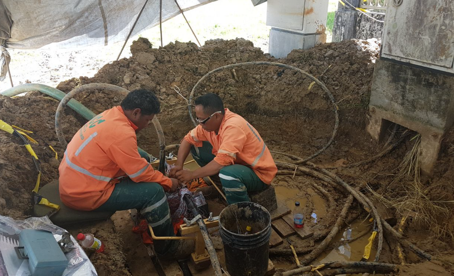
Koperkabel infrastructuur wordt vervangen door glasvezel.
