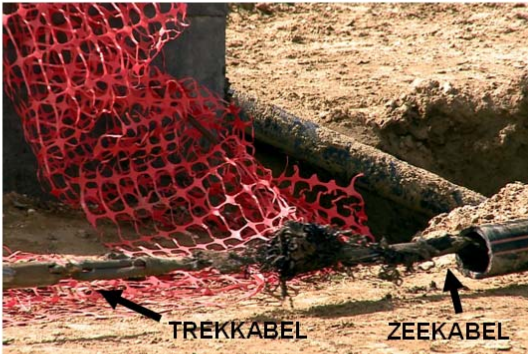
Foto 'zeekabel uitrede omstreeks 3:00 pm': het moment waarop de zeekabel uit de kabelbuis komt nabij de Beach Manhole.
