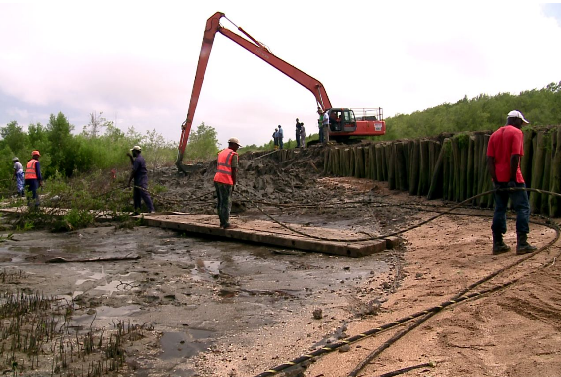
Foto: De verschillende werknemers die bezig zijn de zeekabel te geleiden door de kabelbuis
